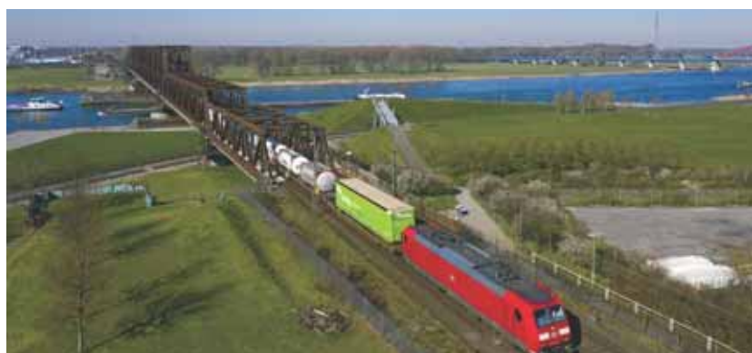
Rheinquerungen wie diese zweigleisige Eisenbahnbrücke bei Duisburg gelten als neuralgische Punkte im Netz: Sie entscheiden mit, ob militärische Verkehre funktionieren.
