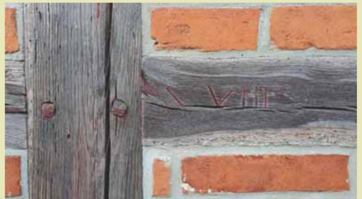
Ein Fachwerkgerüst wurde aus individuell zugehauenen Balken zusammengesetzt. Geritzte Markierungen zeigten die Reihenfolge an, in der die Balken einzubauen sind.
